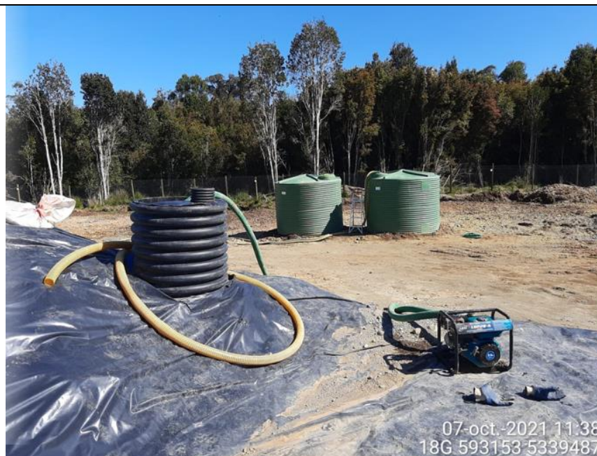
Fotografía N°7: Extracción de Lixiviados desde cámara de inspección sobrecelda C10. Tomada: Jueves 07 de Octubre del 2021
