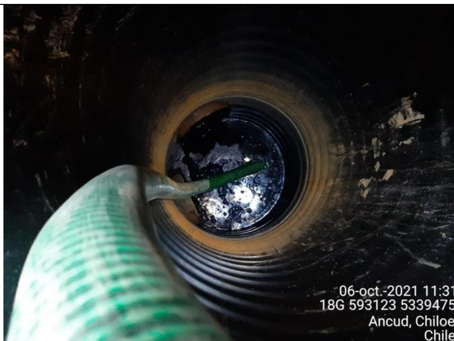
Fotografía N°5: Retiro de Lixiviados desde cámara C03 por Personal Municipal. Tomada: Miércoles 06 de Octubre del 2021.
