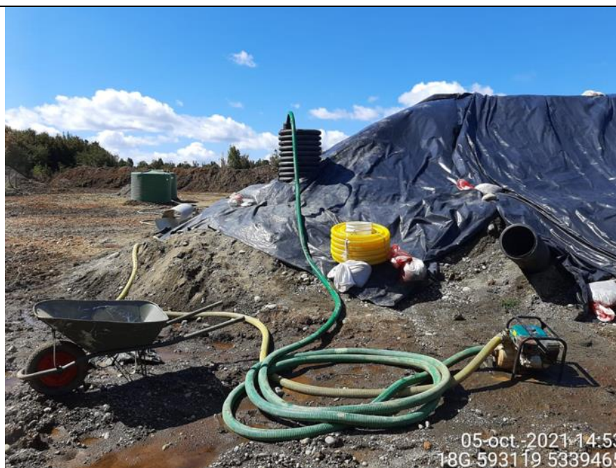
Fotografía N°3: Retiro de Lixiviados desde cámara C08 por Personal Municipal. Tomada: Martes 05 de Octubre del 2021.
