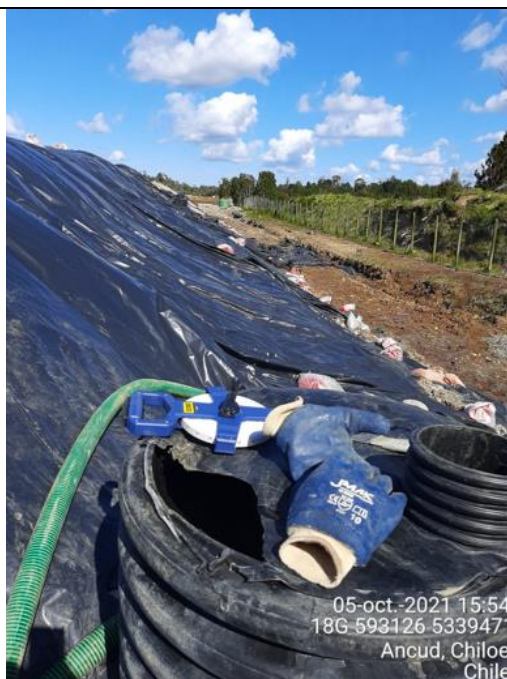
Fotografía N°14: Medición de Niveles de cámaras por Personal Municipal. Tomada: 05 de Octubre del 2021.
