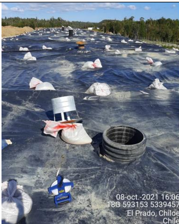
Fotografía N°17: Medición de Niveles de Chimeneas por Personal Municipal. Tomada: 08 de Octubre del 2021.
