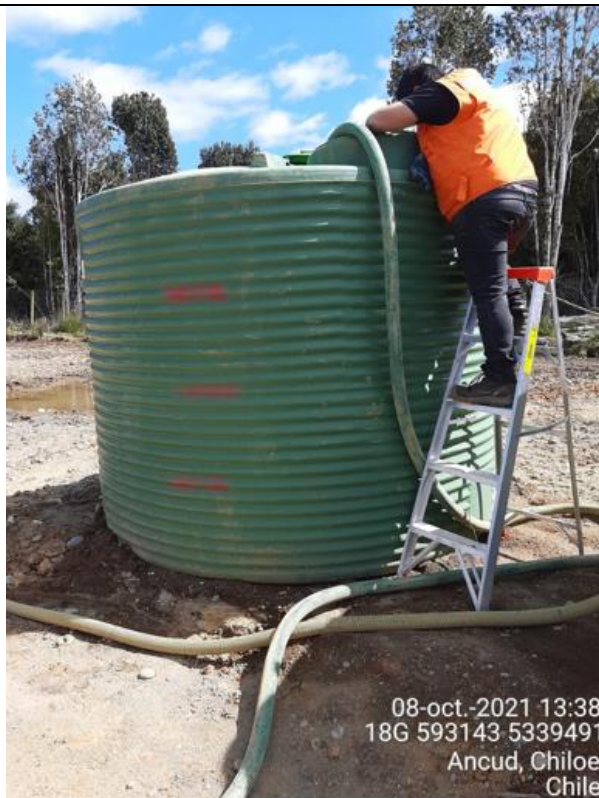
Fotografía N°10: Retiro de Lixiviados desde estanque a camión de Aconser. Tomada: Viernes 08 de Octubre del 2021
